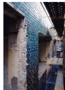
内装解体工事の様子
