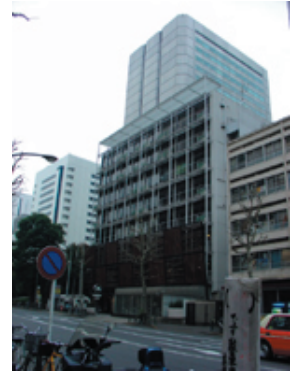
改修後外観 青山一丁目駅から徒歩1分の立地 周辺地域では開発計画が進行中
