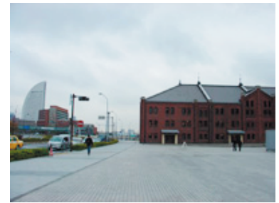
改修後外観 設備等が外観に現れないよう意図された
