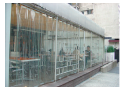
改修後店舗外観
