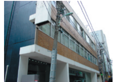
re-know 改修後外観 既存外壁タイルが残されている
