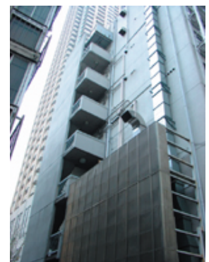
改修後外観（背面）
