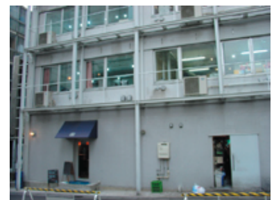
改修後外観（背面） 背面には既存建物の外観が残る
