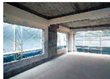
住戸内改修工事の様子
