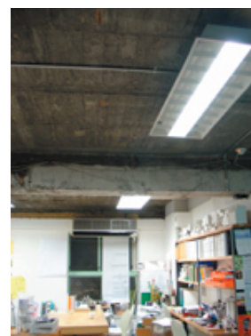
改修後3階内観 既存2階の照明機器を再使用
