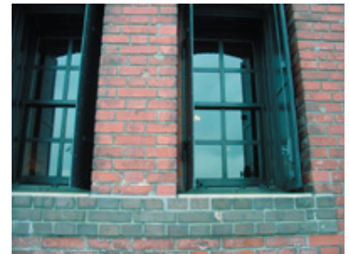
改修後外壁 既存のレンガは補強して使用 サッシは個々の窓を計測して製作された
