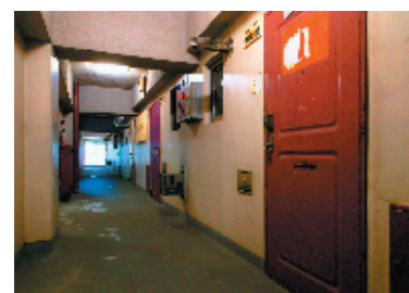
既存建物共用廊下
