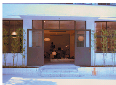
改修後店舗入口
