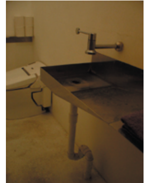
改修後3階内観 設備機器の大部分を更新
