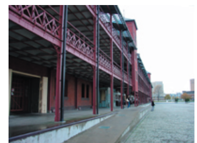
改修後外観 付加された鉄骨造部分
