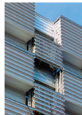
改修後外壁 ガルバリウム鋼板・折板貼
