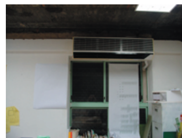
改修後3階内観 エアコンは既存のものを継続使用
