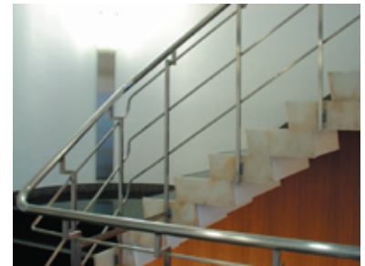
階段と手摺り 既存部分が残された
