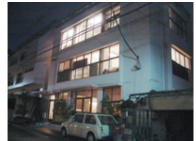
現在の外観 外装の改修は清掃・再塗装のみ
