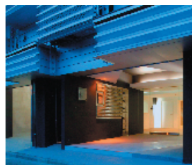
改修後エントランス
