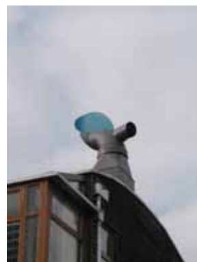
【図 2-3-3】 BedZED の可動換気装置
