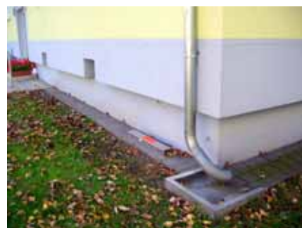
【図 4-2-11】外断熱改修と水循環配慮
