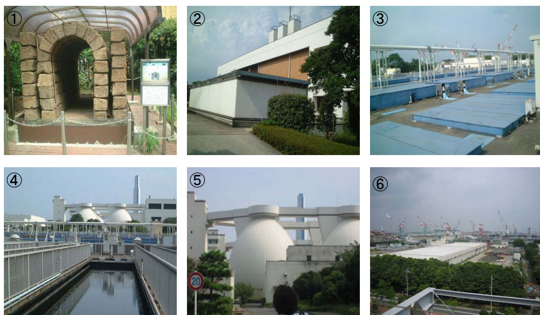
図 29 下水処理場・汚泥処理場
