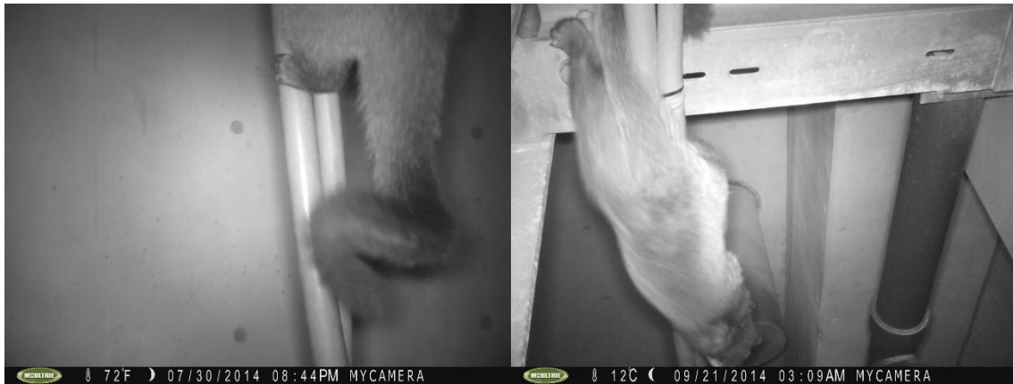
付録写真 4. 鉄筋コンクリート製の建物内で、電源ケーブルを昇降するハクビシン
