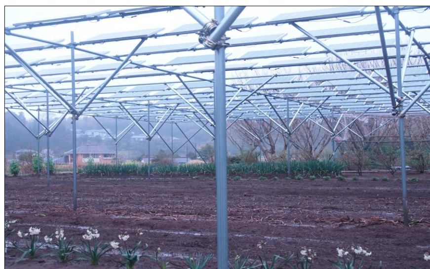
Figure1.3 : 日本の営農型太陽光発電設備
