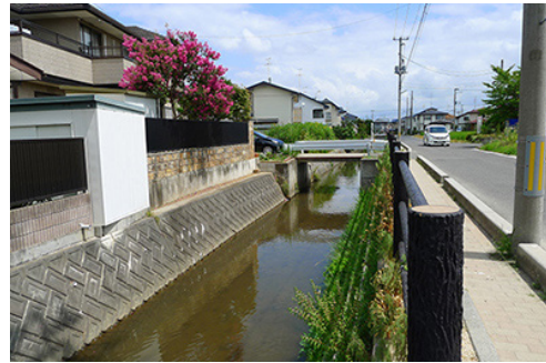
図 2-2-3 A' 地区：道路脇に側溝として水路が残る
