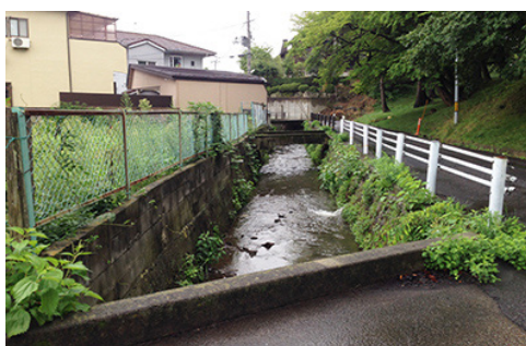
図 2-2-6 C 地区：水路の軌道を利用して車道整備 (開渠)
