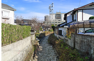
幅員は4m程あるが、住宅とはブロック塀で仕切られ人の立ち入る空間にはなっていない
