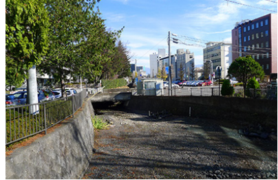
市庁舎前の分流堰。冬場は通水されていない。
