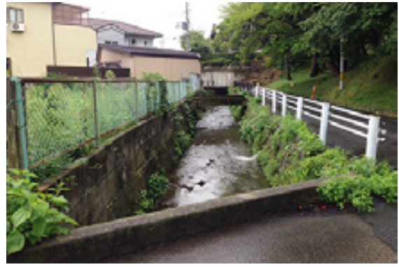
水路が残る箇所では車道の幅員がせまくなっている
