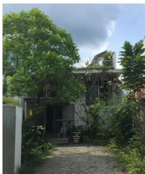
図 3-67 事例 AG 外観 出典:設計者提供
