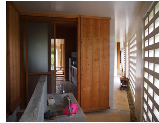
図 2-29 事例 G 西側 花ブロック壁
