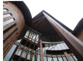
図 3-38 事例 AA 外観/木造大柱 出典:設計者提供
