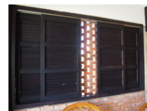
図 2-64 事例 O 西面 開口部
