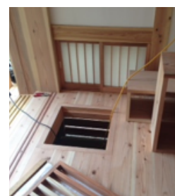
図 2-3 事例 A 床下換気口
