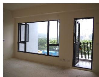
図 2-45 事例 K 南面 開口部
