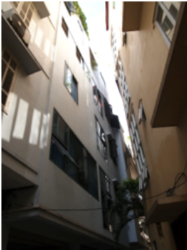
図 2-56 事例 N 外観
