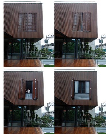
図 3-24 事例 X ダブルスキン/開口部 出典:設計者提供
