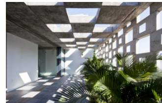
図 2-69 事例 P 5 階 パターンブロック壁
