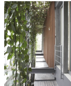
図 3-86 事例 AJ 外観 外壁 出典:設計者提供
