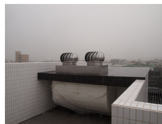
図 2-46 事例 K 南面 開口部
