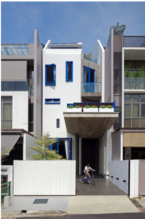
図 3-47 事例 AC 外観 出典:設計者提供
