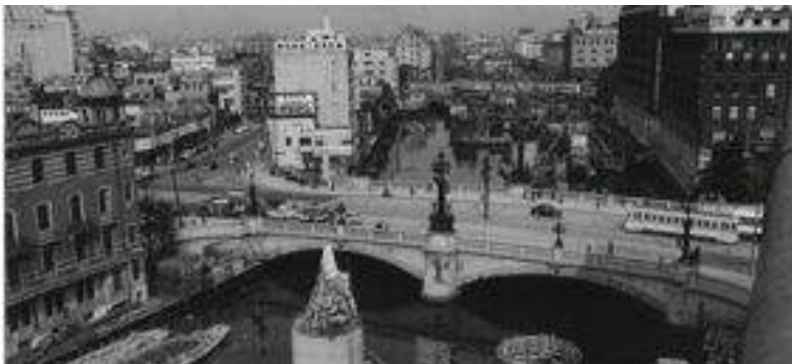
図1-10：高速道路建設中の日本橋[4]
